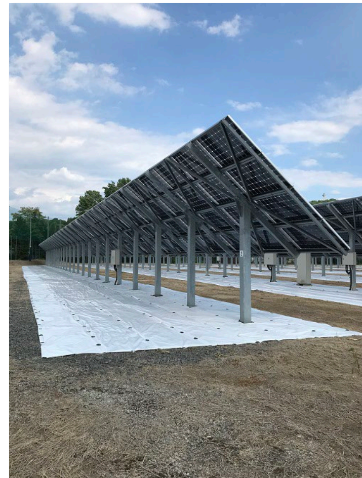
両面採光型太陽電池モジュール DNP太陽光発電所用反射シート
