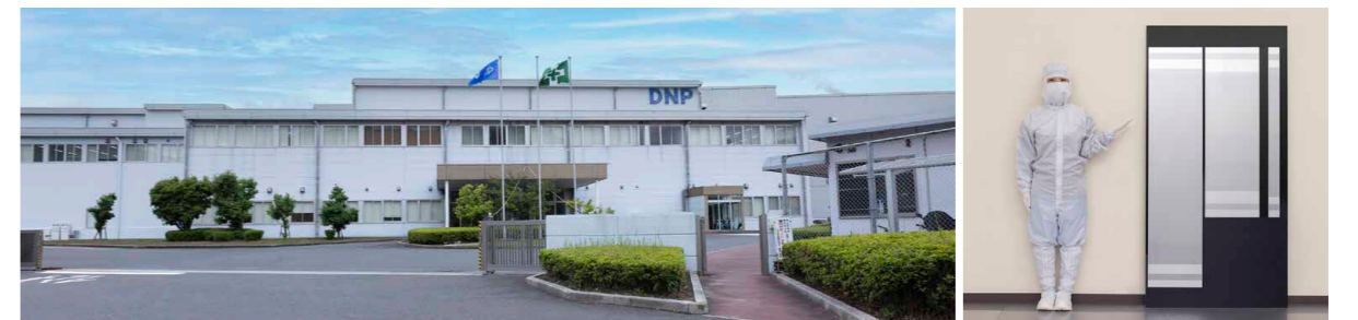
黒崎工場(福岡県)の外観
