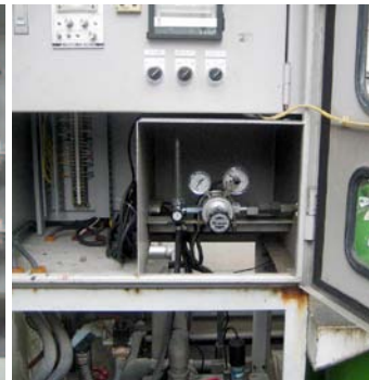
炭素ガス気化器の点検の強化
