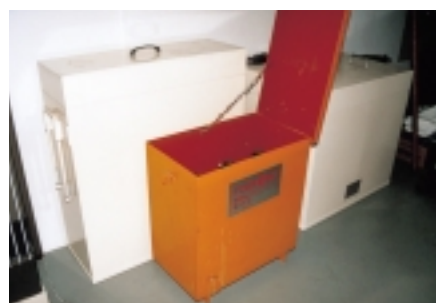
市谷営業ビル PCB保管状況
