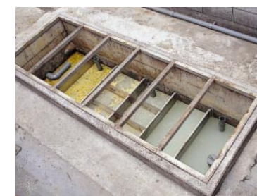
大日本カップ 狭山工場 コンプレッサードレーンの油水分離処理
