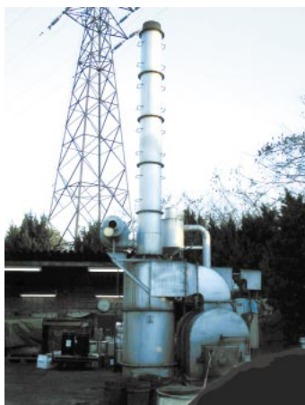
ザ・インクテック関西工場 焼却炉の廃止前
