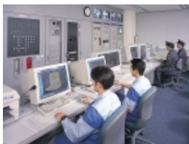
C&Iビルの防災センター
