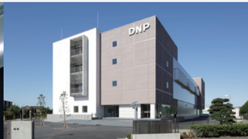
DNP 柏データセンター
